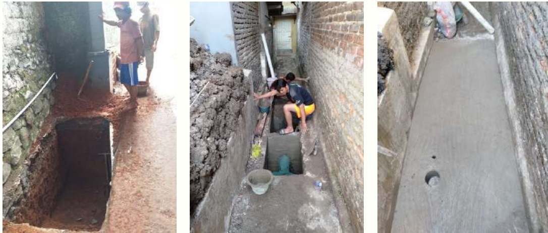
Pembuatan septictank di RW 06
