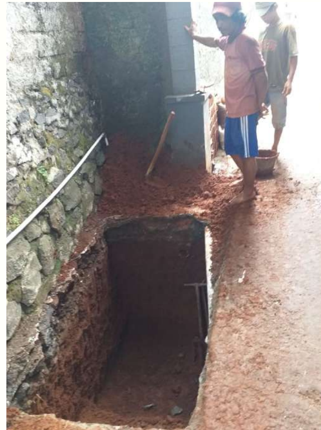
Pembuatan Septic Tank di RW. 04 Kelurahan Sindangjaya
